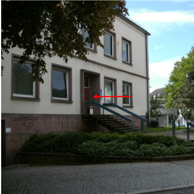
Abbildung 3: Wilhelmstraße 26, Blick von Belfortstraße
