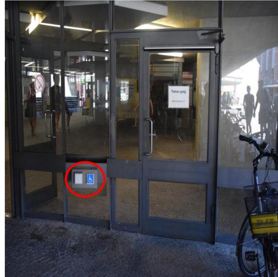
Abbildung 5: Notausgang mit elektronischem Schließsystem
